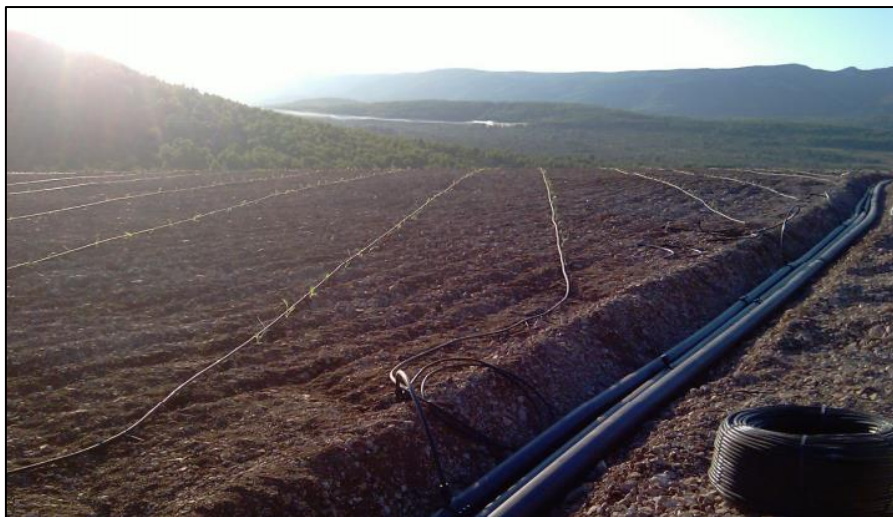
Slika 10. Prikaz primjera postavljenih cjevovoda
